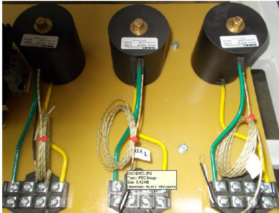
Fig.4.3. Vedere componente de forță: bobine inductoare
